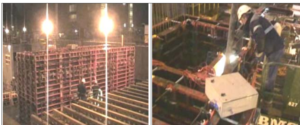
Figur 1-2: Der er støbt én indre kernevæg (NØ) med forskellige udspartinger.
