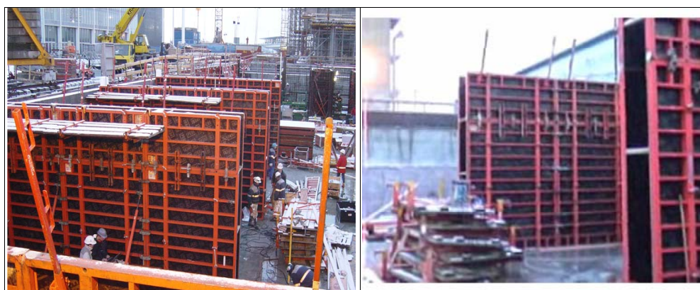
Figur 1-1: Der er støbt fem ens indvendige letarmerede plane kældervægge, her vist V1-V3.
