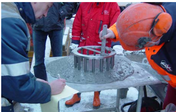
Måling af SCCs friskbetonegenskaber med J-ring, DR-Byen, Segment 3.
